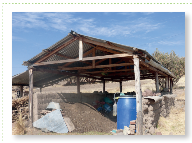
Módulo para la preparación y almacenamiento de abonos.
